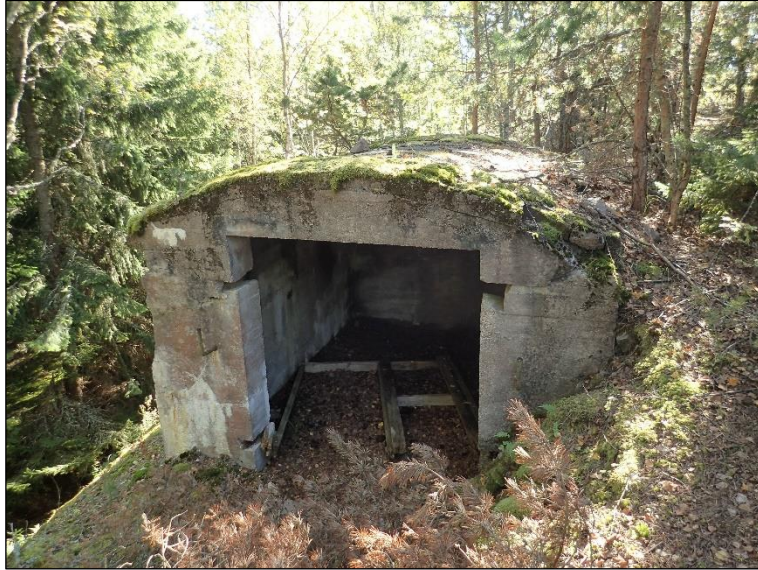
Kallion laen itäpuolella sijaitseva betoninen varastorakennus. Kaakkoon.
