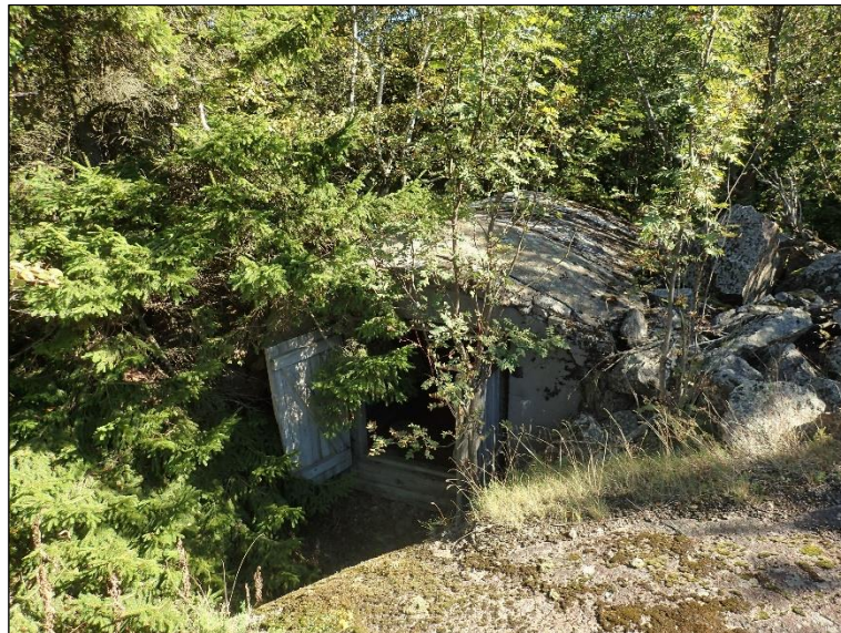
Kallion kupeessa sijaitseva betoninen varastorakennus. Itään.
